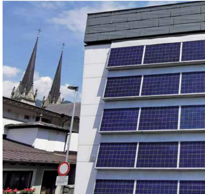
Die bestehende PV-Anlage an der Fassade der Polytechnischen Schule wird erweitert. Auf den Dachflächen werden weitere Zellen montiert. Foto: G. Köhler
